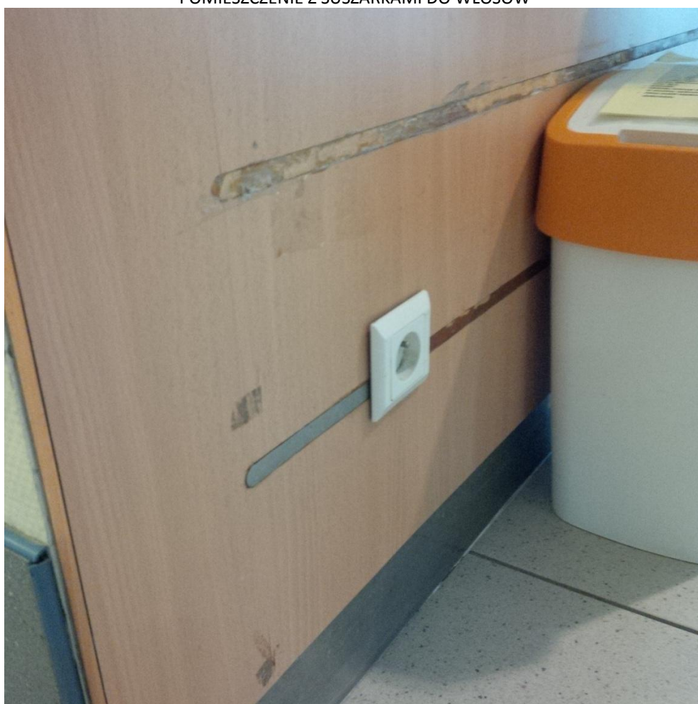
POMIESZCZENIE Z SUSZARKAMI DO WŁOSÓW
